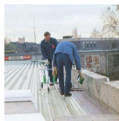
Kleberverbrauch im Rand- und Eckbereich, in der Regel ca. 120 g/m 2
