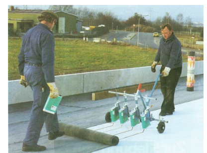
Verklebung einer talkumierten Bitumen-Schweißbahn auf Hartschaumplatte.
