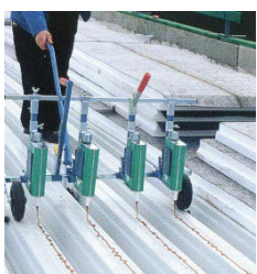
Kleberverbrauch in der Fläche, in der Regel ca. 100 g/m 2
